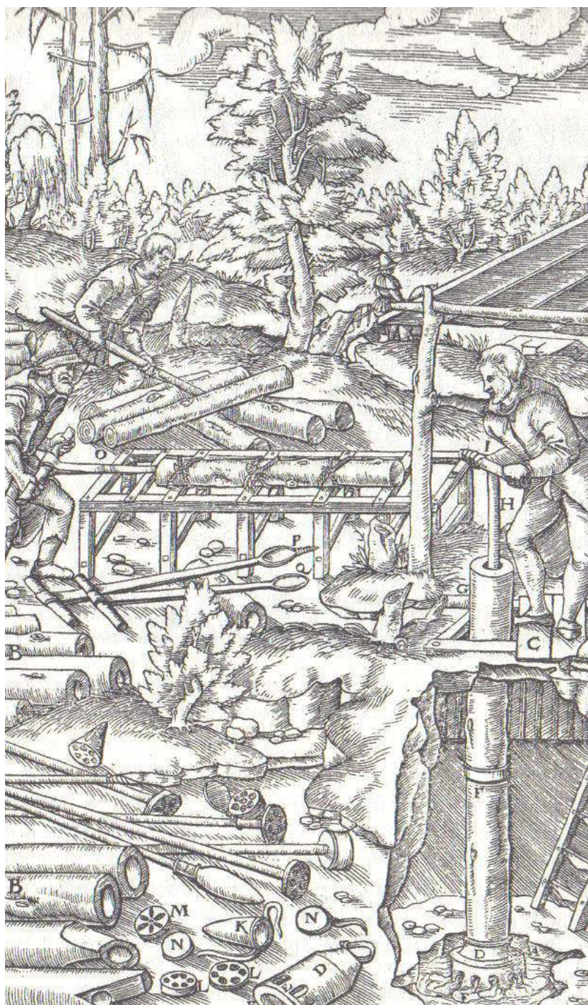
Obr. 3.35 Ručné vŕtanie rúr v Taliansku r. 1556. a čerpanie vody z podzemia. A – žumpa, B – rúry, C – povala, D – klát, E – otvory v kláte, F – záklopka, G – výtok, H – ťahadlo, I – rukoväť ťahadla, K – piestový kužeľ, L – piest s kruhovými otvormi, M – piest s oválnymi otvormi, N – záklopka, O – ručné vŕtanie upevneného kmeňa, P – tvar skrutkovitého vrtáka, Q – vŕtacie korýtko [1]
