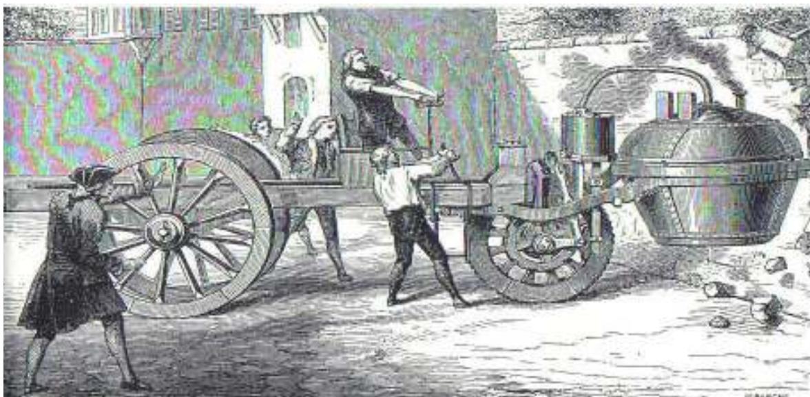
Obr. 1.224 CUGNOTOV parný voz na prepravu kanónov [21]
