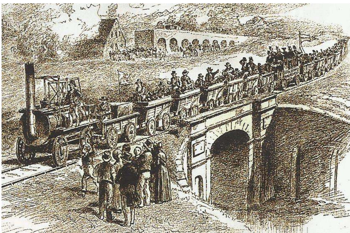
Obr. 1.264 Prvý parný vlak pre 600 cestujúcich na 13. km trati
