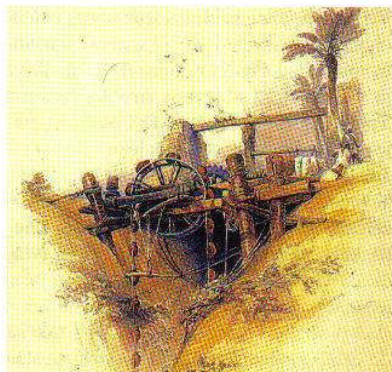
Obr.1.22 Čerpadlo na vodu, poháňané zvieratmi
