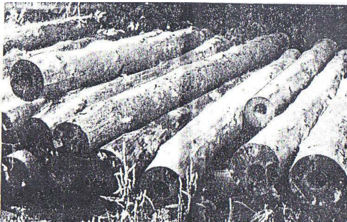
Obr. 3.30 Posledná fotografia drevených rúr, pripravených na výmenu z r. 1952 [11]
