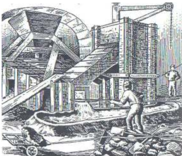
Obr. 2.56 Kuplová pec pri odpichu liatiny do formy. Nad pecou je navážacie zariadenie
