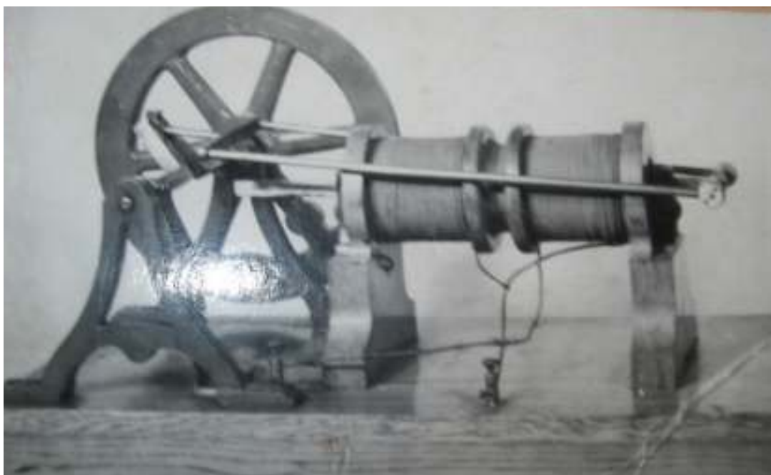
Obr. 1.401 Lineárny elektromotor
