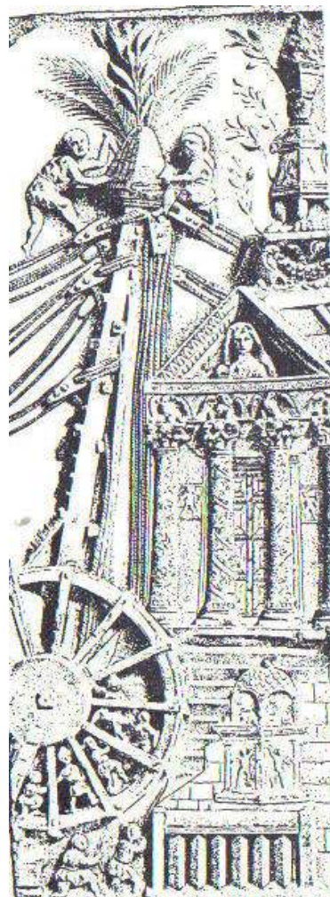
Obr. 2.48 Šliapací žeriav rímskych rezbárov z r. 100 n.l. Dole: Šliapací žeriav, použitý v Bruggách začiatkom 15. storočia Dokumentuje rozvoj techniky v priebehu cca 1000 rokov
