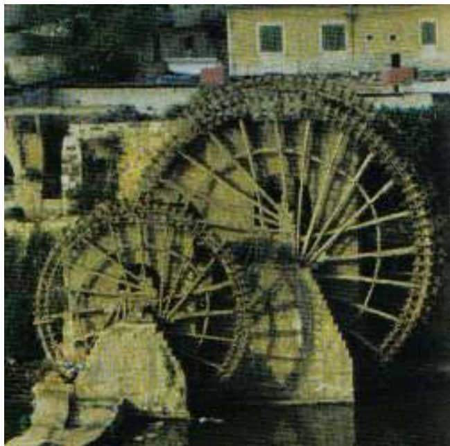
Obr. 1.112 Norea v meste Hama na rieke Orontos (Sýria). Porovnanie s ľudskou postavou a ďalšia súprava zavlažovacích vodných kolies zo Sýrie, dnes už slúžia ako atrakcia
