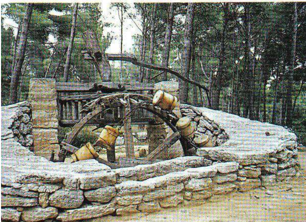
Obr. 1.114 Stará noria na ostrove Malorca v Stredozemnom mori. Gepel' bol poháňaný somárom. Fungoval ako čerpadlo na vodu ešte od Rímskych čias [21]
