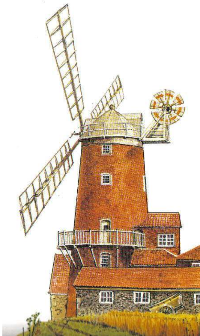
Obr. 1.283 Veterný mlyn s automatickým otáčaním za vetrom (Science Museum Londýn – foto autor)
